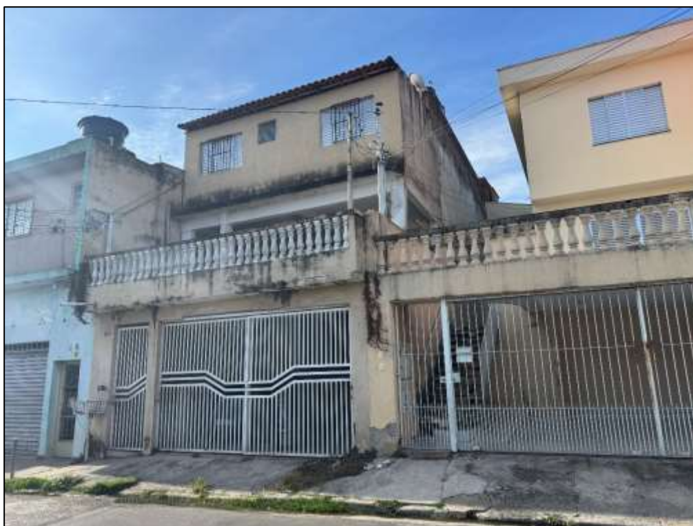
Aspectos gerais da fachada.
