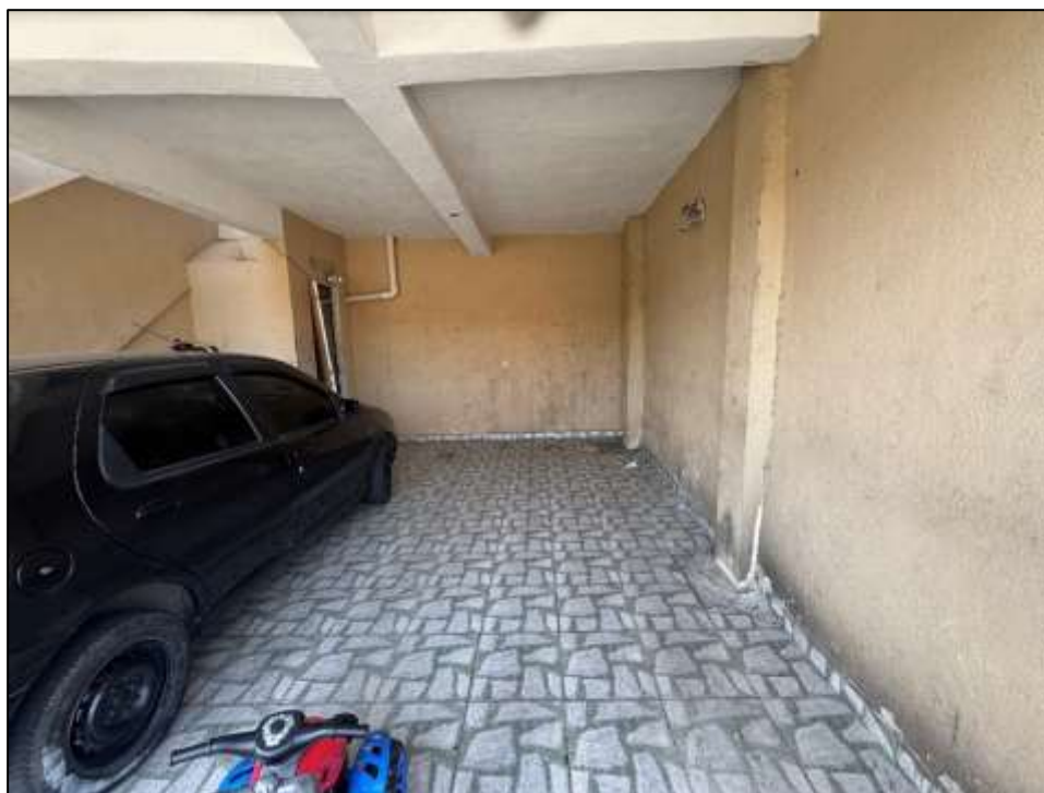
Características gerais da edificação - garagem.
