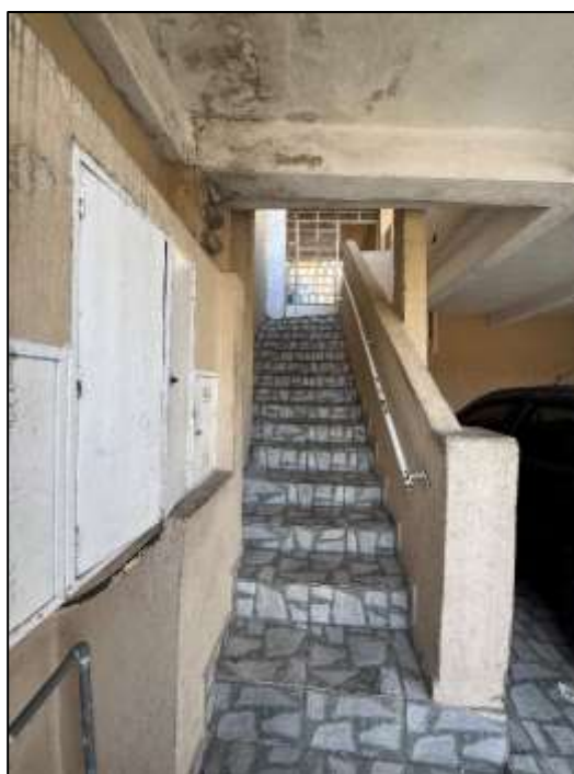
Características gerais da edificação.
