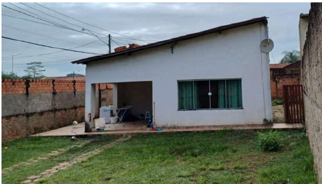
Fachada frontal do Imóvel Avaliado - Rua dr. Novais Rocha, 1104 - Campinas/SP.
