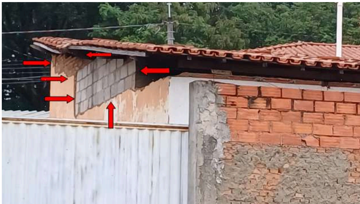
FOTO 28: Destaque para tijolos maciços de barro e blocos de concreto na área em reforma.
