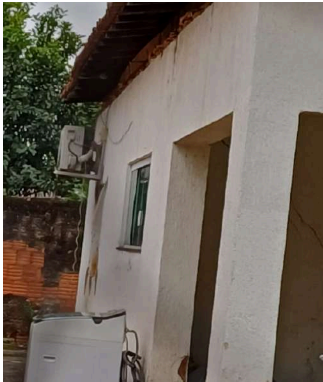
FOTO 25: Ar-condicionado e janela.
