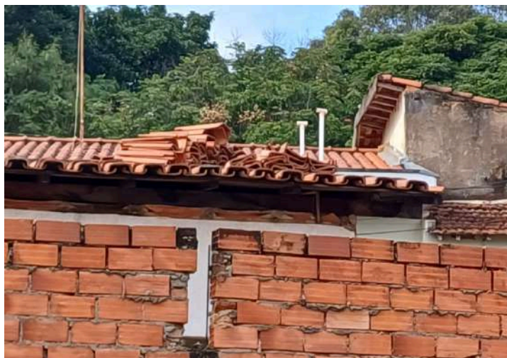
FOTO 27: Pilha de telhas no telhado.
