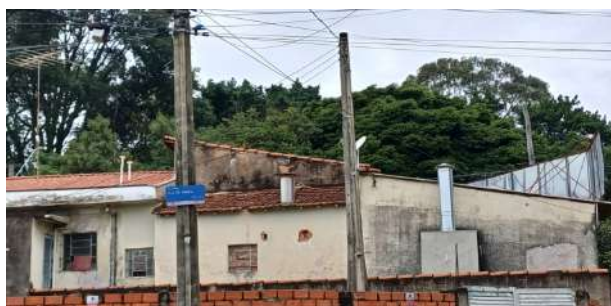
FOTO 04: Vista lateral esquerda, vizinhos.
