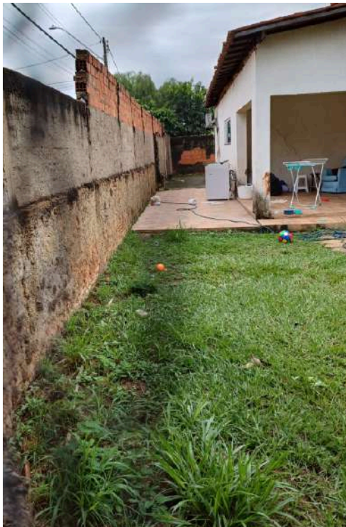
FOTO 24: Vista geral lateral direita.
