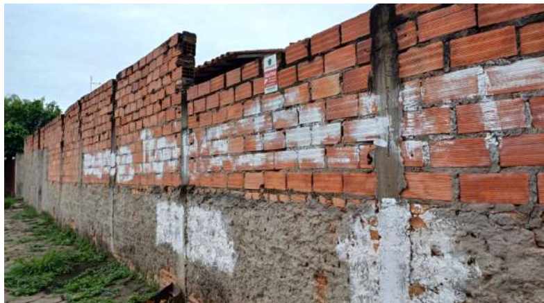
FOTO 18: Muro do Imóvel Avaliando.
