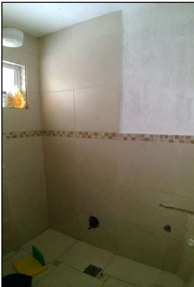
Vista do banheiro do escritório.
