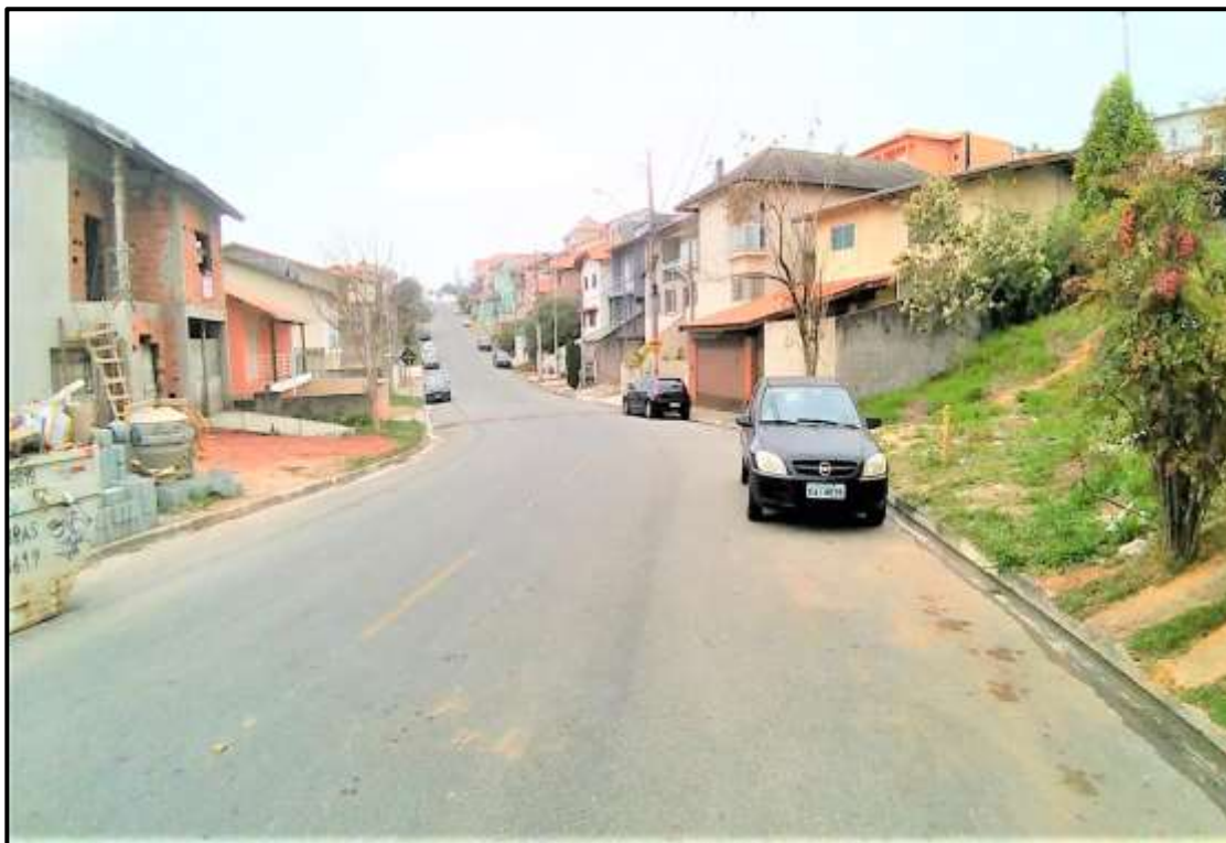
Vista da rua Milano, no trecho considerado.
