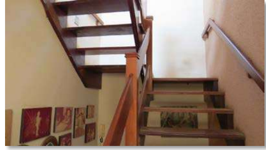
Imagem 12 – Escadas de acesso entre os pavimentos
