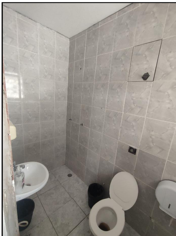
Ilustração 47: 2º pavimento (2º andar) – Banheiro da sala 03
