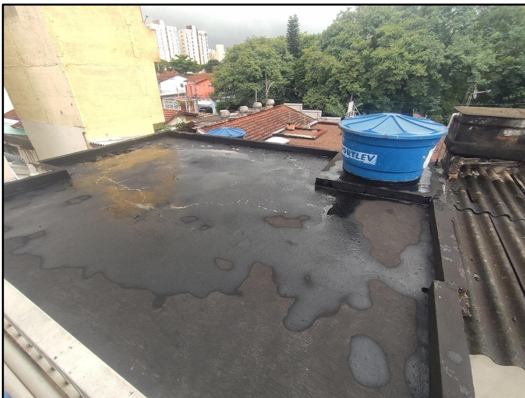
Ilustração 52: 2º pavimento (2º andar) – Varanda da sala 05
