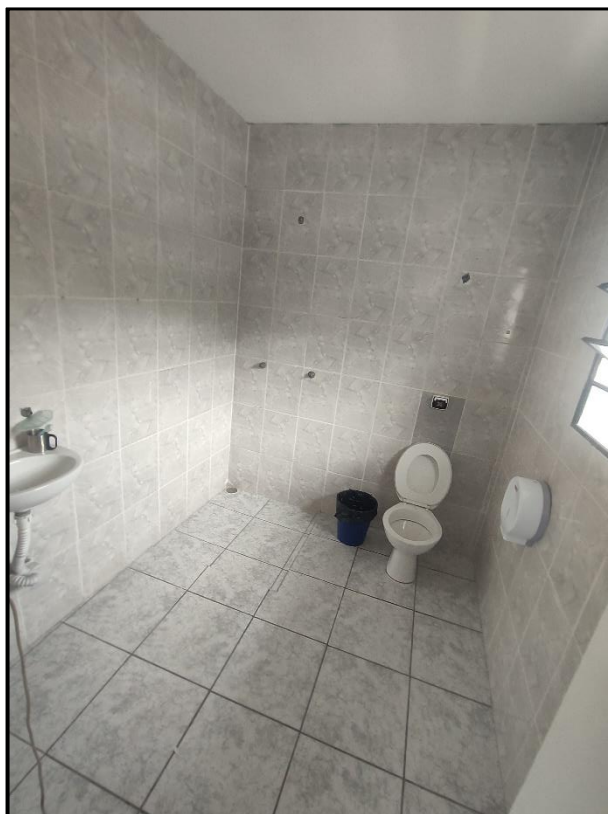
Ilustração 51: 2º pavimento (2º andar) – Banheiro da sala 05
