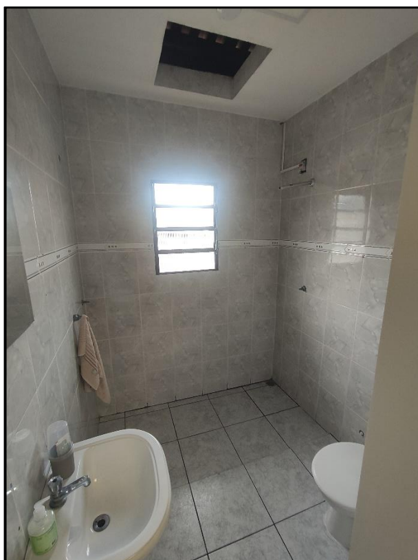
Ilustração 45: 2º pavimento (2º andar) – Banheiro da sala 02
