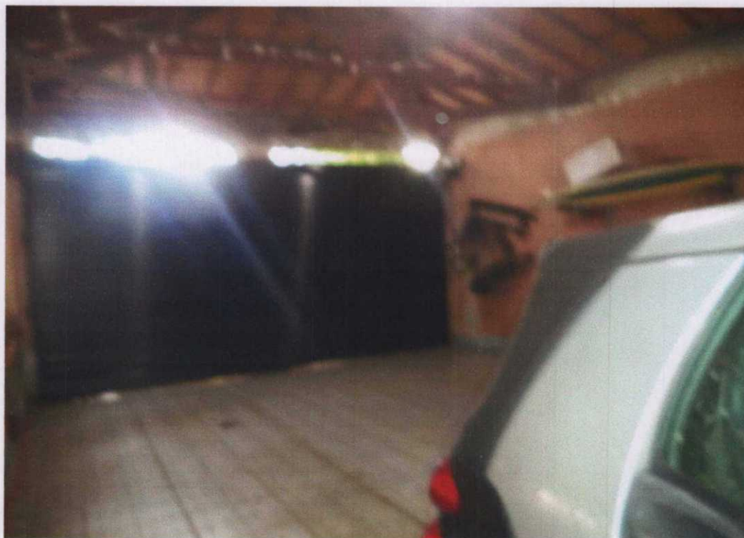
Foto 03 - Vista do interior da garage.
