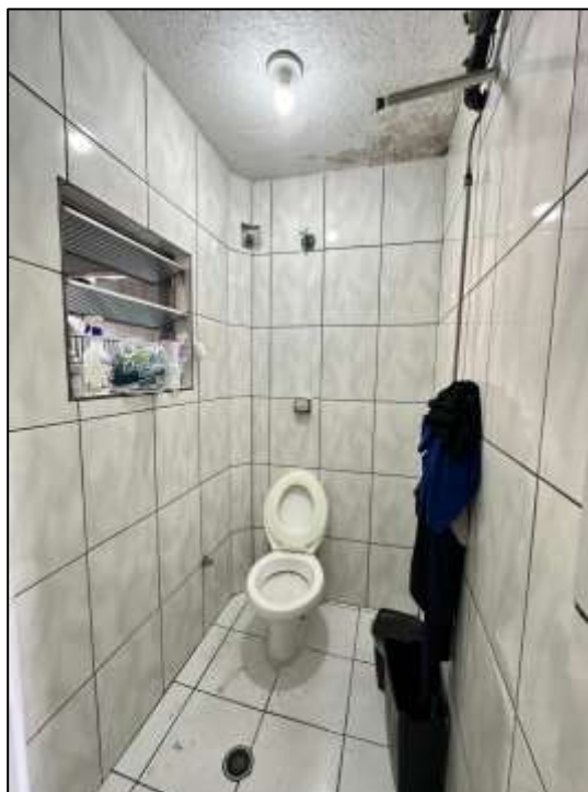
Matrícula nº 17.853 – mezanino - banheiro.
