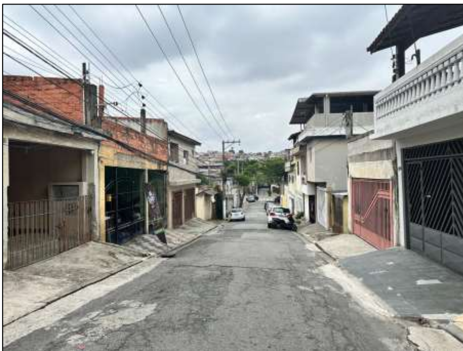
Rua Sargento Claudiner Evaristo Dias, no trecho em que se localiza o imóvel.
