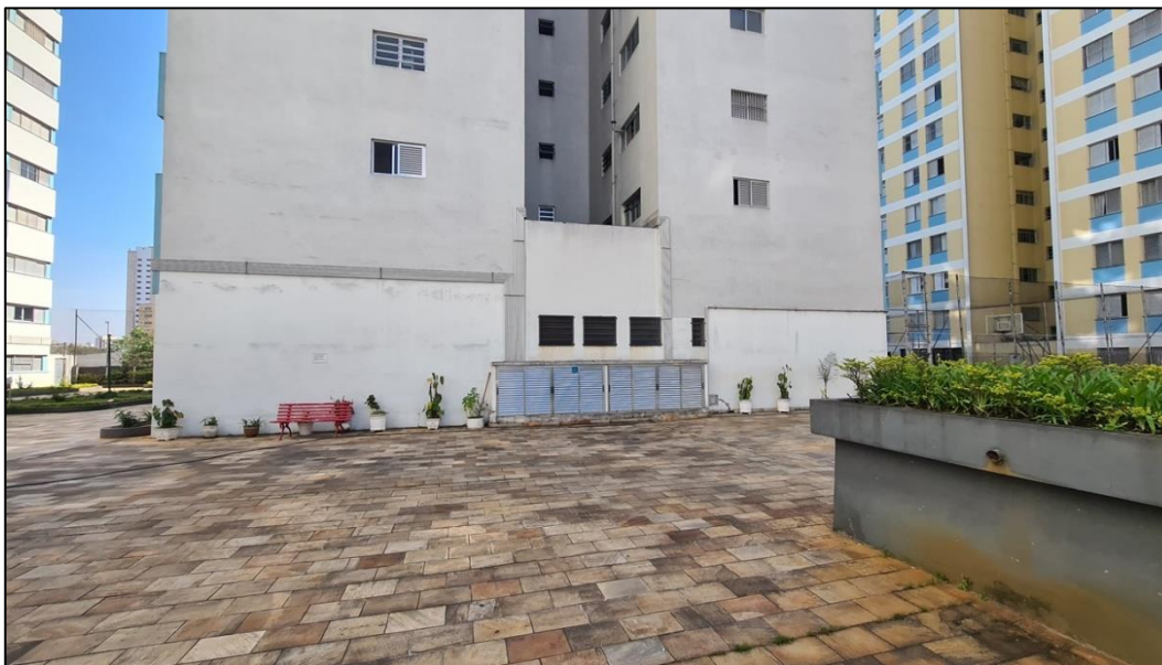
Foto 01 – Fachada do Bloco D
