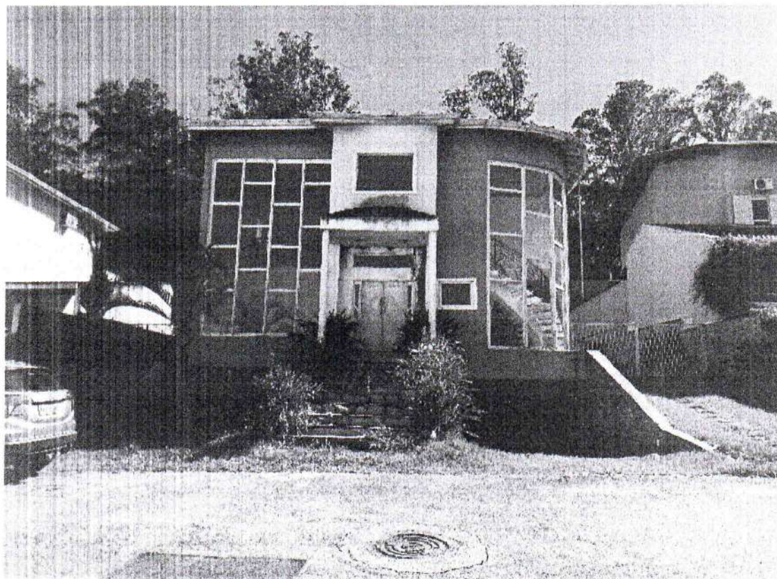
VISTA DA FACHADA DO IMÓVEL AVALIANDO.
