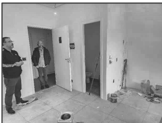
Vista Interna de uma das salas
