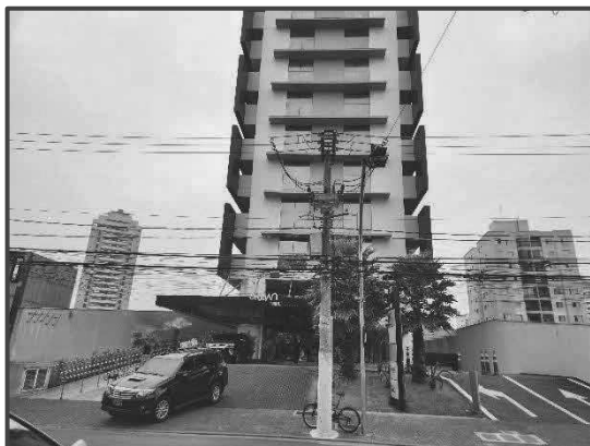
Vista geral do edifício
