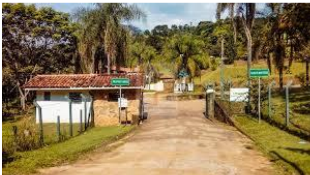
Foto 04 - Fachada do condominio
