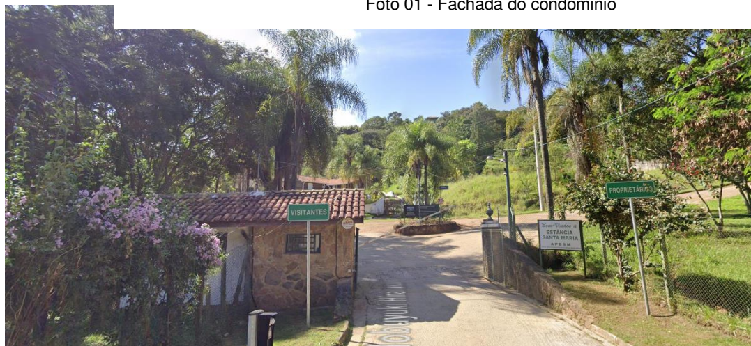
Foto 01 - Fachada do condomínio
