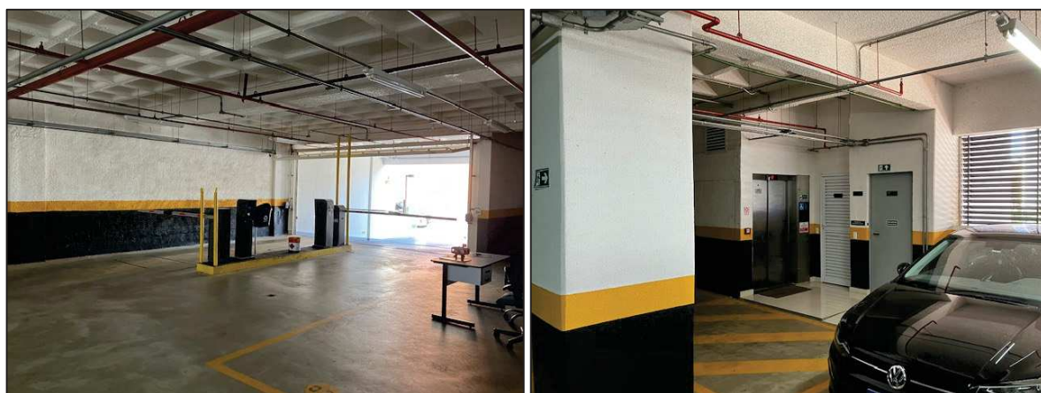
Figura 9- 3º Subsolo (entrada e saída do estacionamento)
