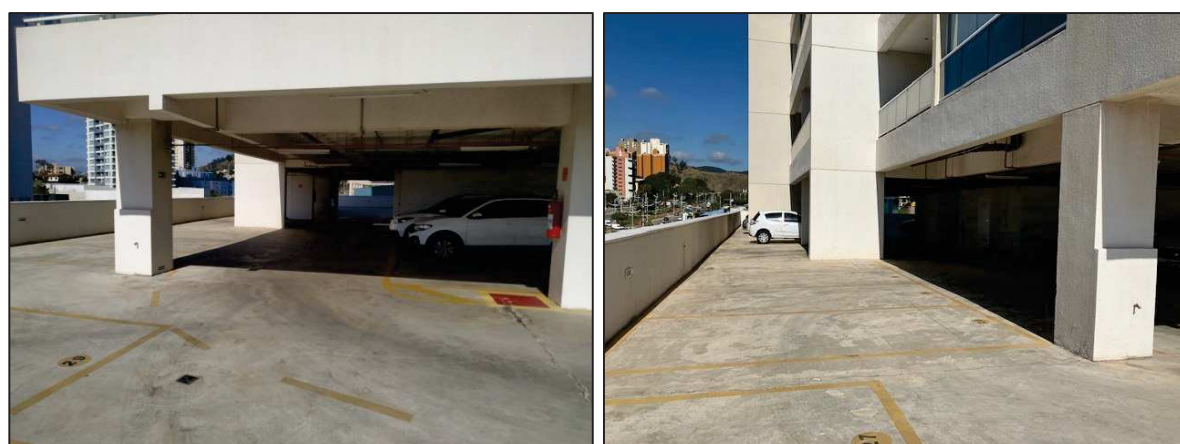
Figura 14 - Vistas para as áreas de garagem do 1º Subsolo.
