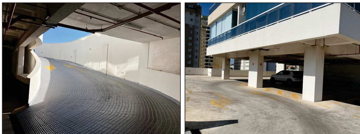
Figura 13- Rampa de acesso ao 1º Subsolo.
