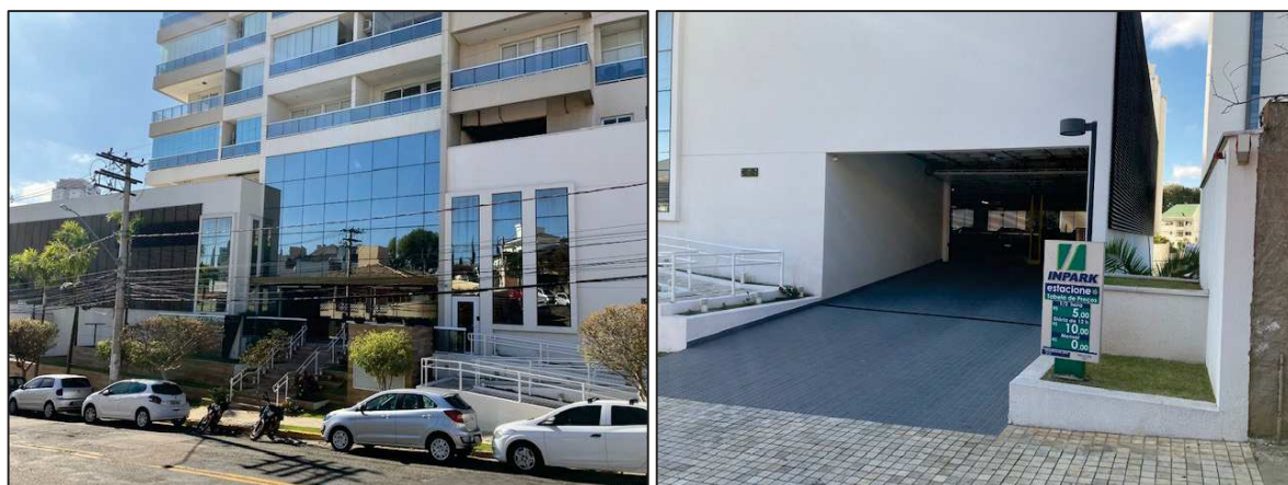
Figura 6 - Fachada do local do Estacionamento (Avenida Dr. Paulo Mouran).
