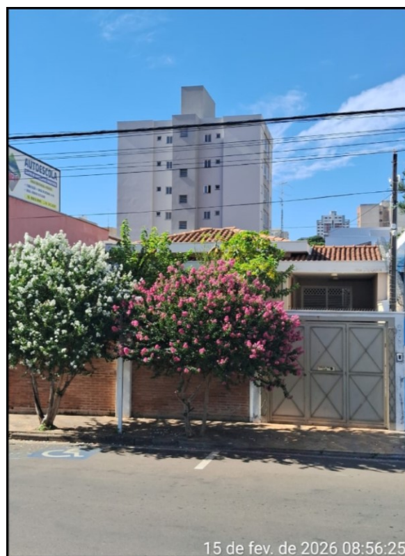
Figura 3 - Fachada Frontal do Imóvel.
