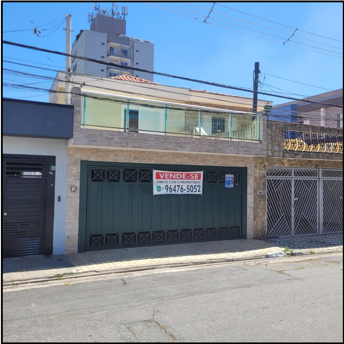
FOTO 01 : Vista do imóvel avaliando.
