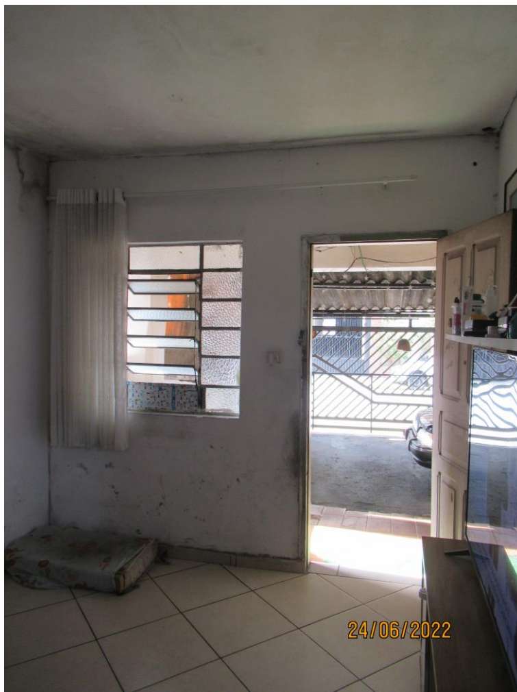
Foto nº. 6 – Outra vista da sala.
