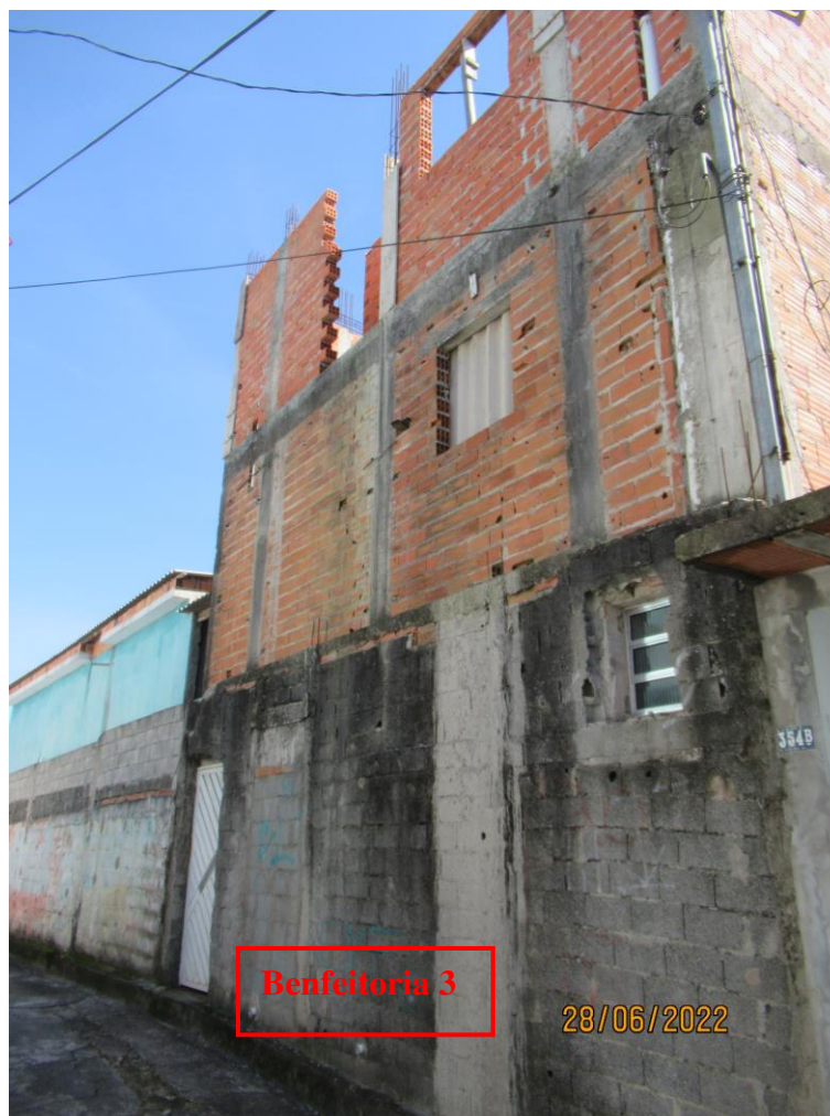
Foto nº. 28 – Vista da fachada da benfeitoria 3.
