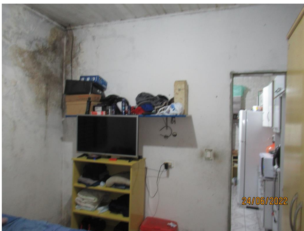
Foto n.º 10 – Outra vista do dormitório 2.
