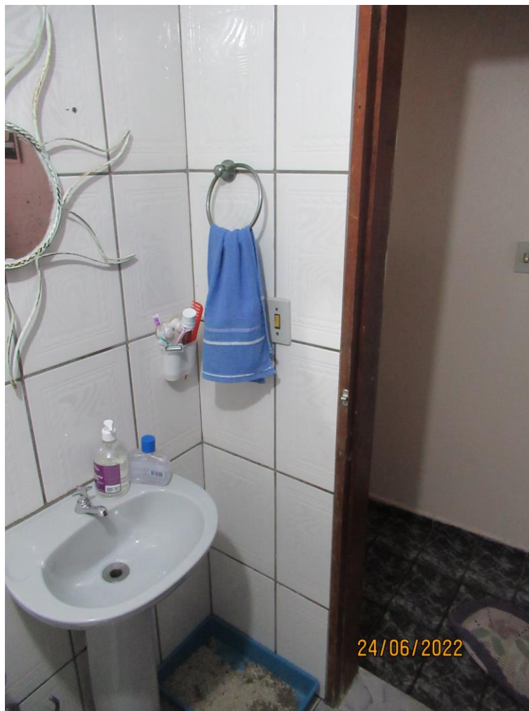
Foto nº. 22 – Outra vista do banheiro social.
