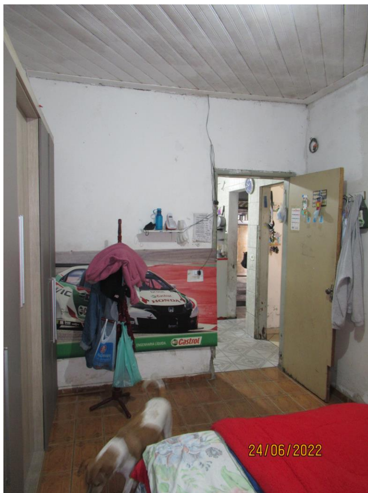
Foto nº. 8 – Outra vista do dormitório 1.
