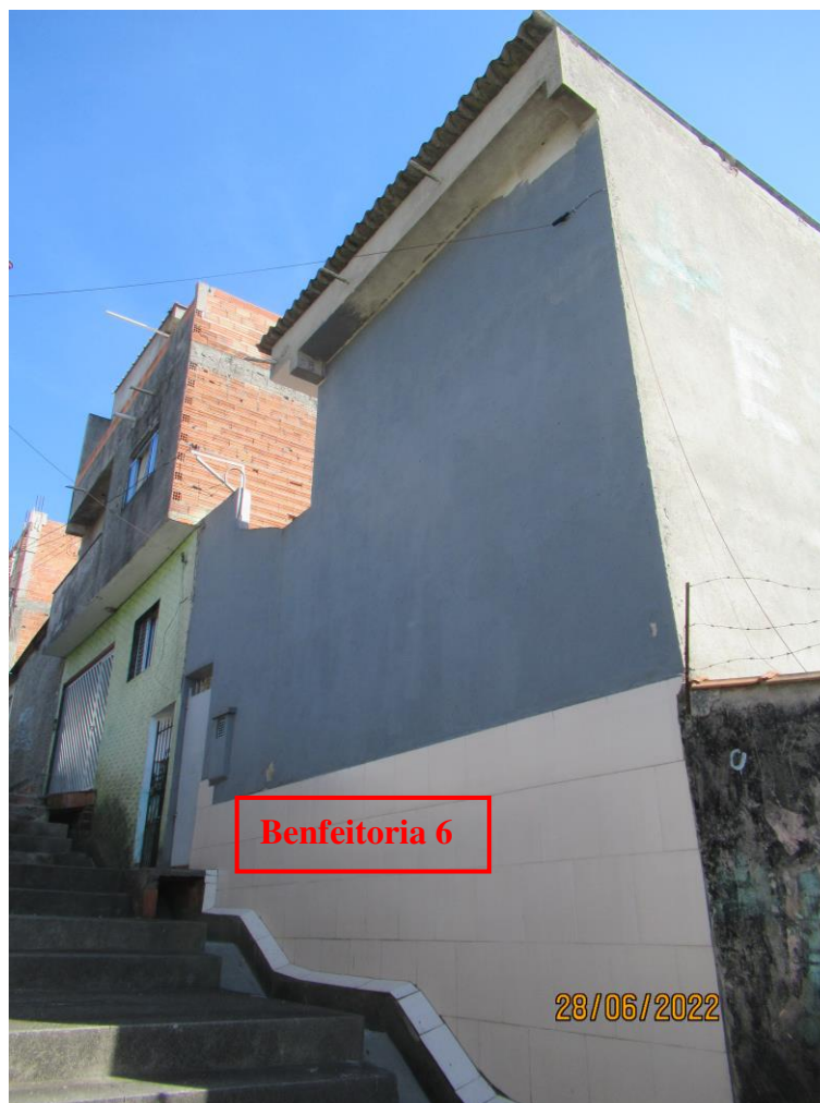
Foto nº. 36 – Vista da fachada da benfeitoria 6.
