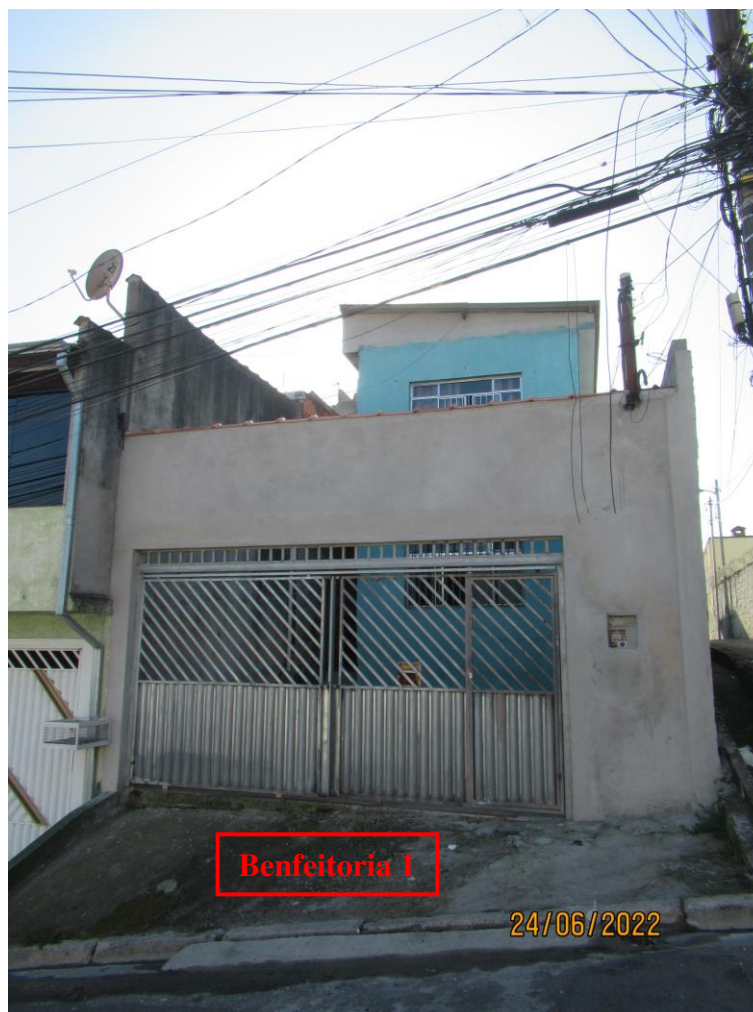
Foto nº. 6 – Vista da fachada da Benfeitoria 1.
