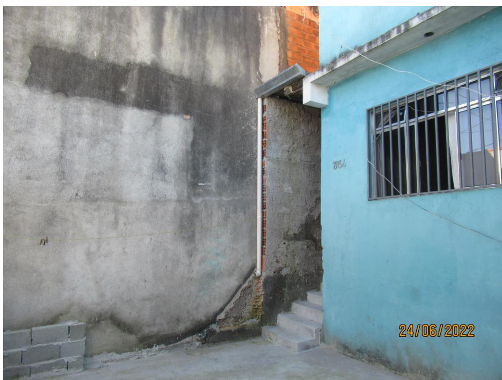
Foto nº. 7 – Vista do recuo frontal.
