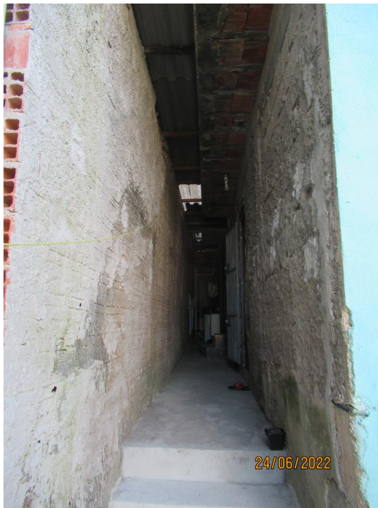
Foto nº. 8 – Vista do corredor lateral.
