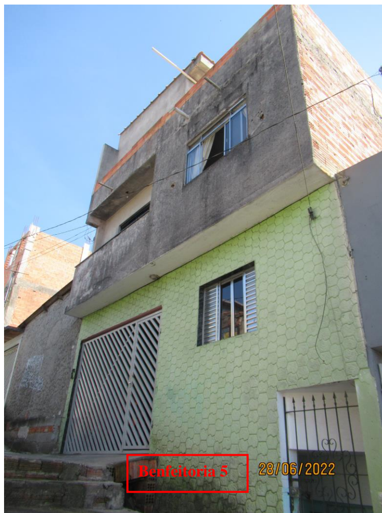
Foto nº. 30 – Vista da fachada da benfeitoria 5.
