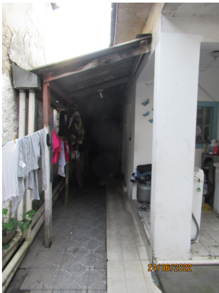
Foto nº. 25 – Vista da lavanderia.
