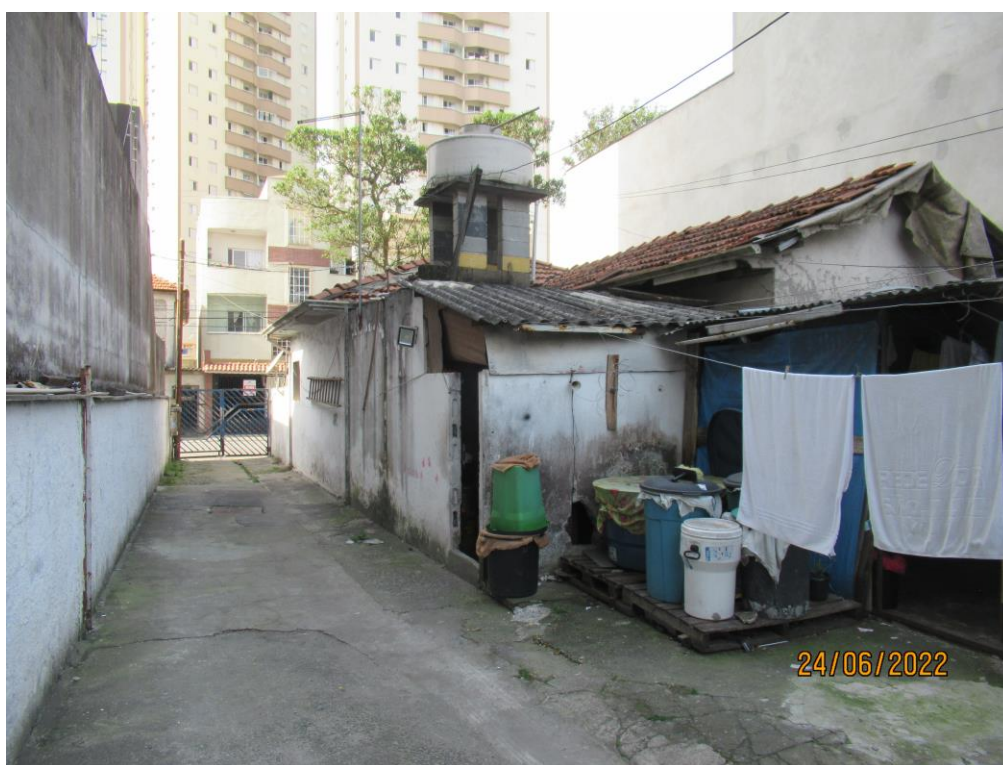
Foto nº. 16 – Vista do corredor lateral.
