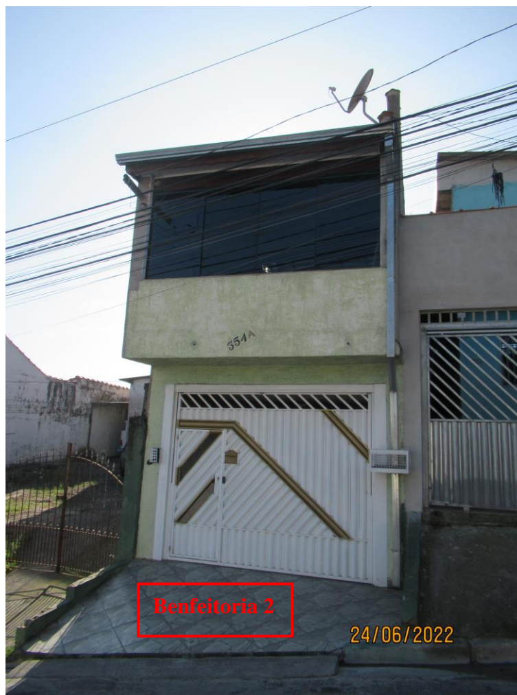
Foto nº. 27 – Vista da fachada da benfeitoria 2.
