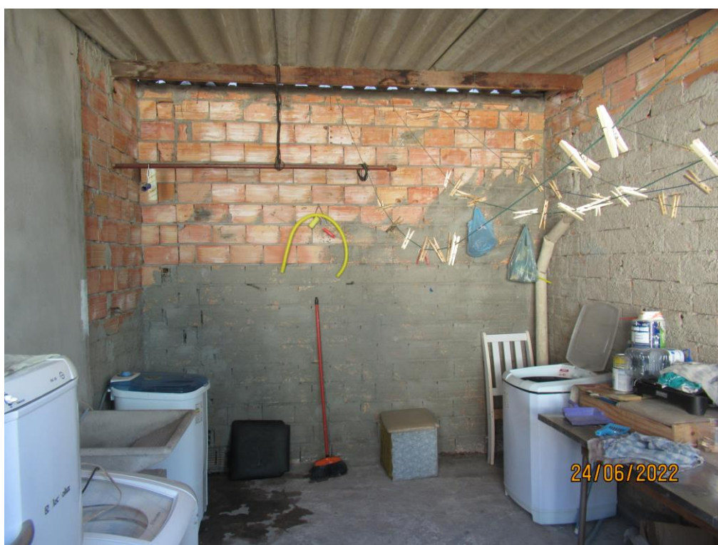
Foto n.º. 26 – Outra vista da área de serviço.
