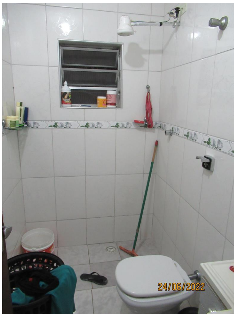
Foto nº. 13 – Vista do banheiro social.
