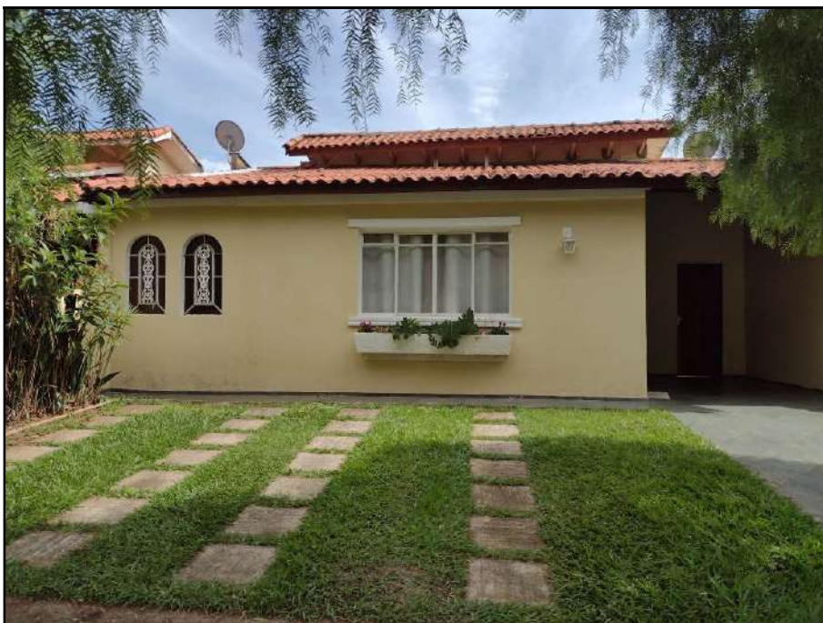
Vista da frente do imóvel avaliando.
